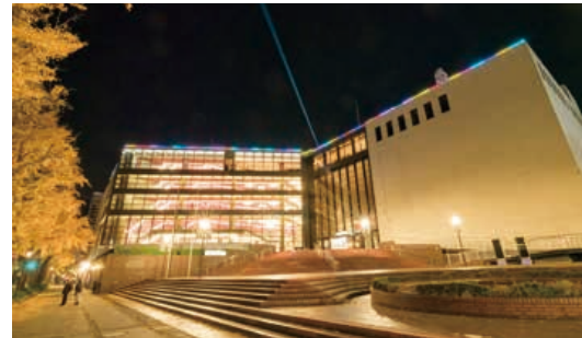
36 神奈川県民ホール 特別協力(照明設置)：京浜電設株式会社 協力：神奈川県民ホール(公益財団法人神奈川県芸術文化財団)
