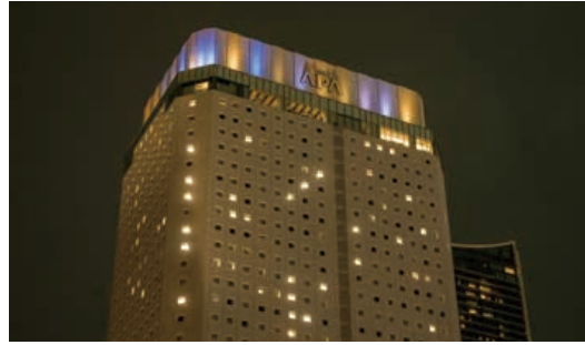
22 アパホテル&リゾート〈横浜ベイタワー〉 特別協力(照明設置)：京浜電設株式会社 協力：アパホテル株式会社
