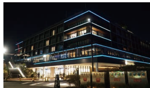
15 横浜ハンマーヘッド 協力：横浜ハンマーヘッド(新港ふ頭客船ターミナル株式会社)
