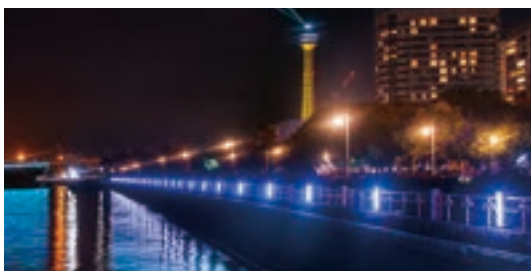
32 山下公園(水際線) 特別協力(照明設置)：株式会社日動電設
