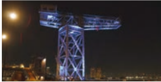
13 ハンマーヘッドクレーン
